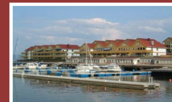
Havnen, med nye boliger langs Bryggeveien
